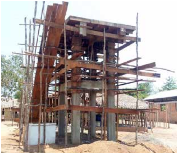
Die im Bau befindliche Anlage in Arimum
