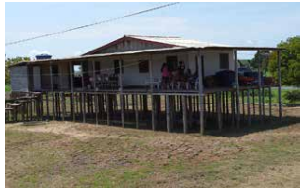
In der Regenzeit stehen die Häuser unter Wasser und sind nur mit dem Boot erreichbar.
