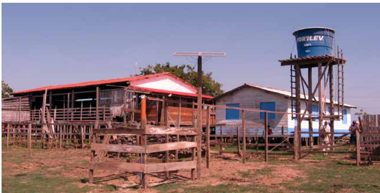
Solare Brunnenanlage in Nova Vista
