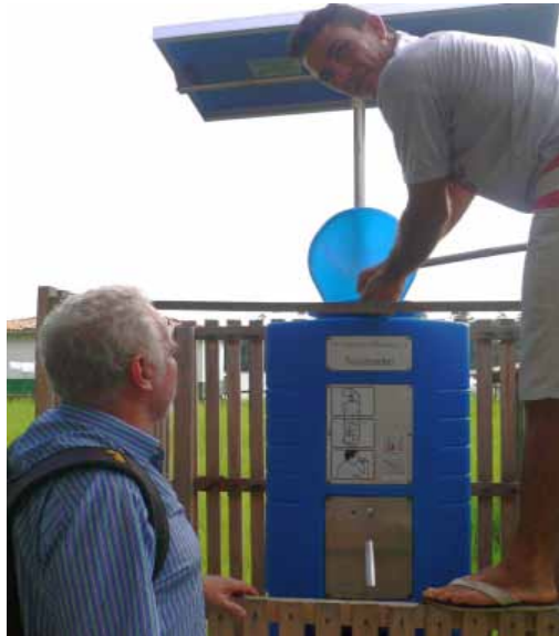
Solare Wasserentkeimungs- und Reinigungsanlage
